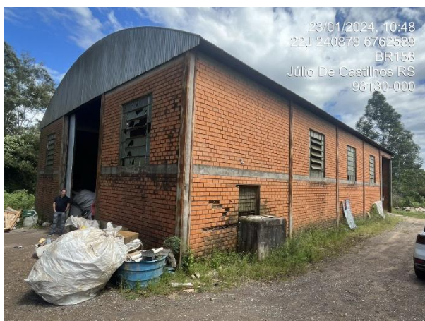
Figura 71: Fachada da ACASMAR
