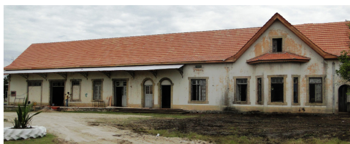
O telhado reformado da Estação Férrea de Restinga Sêca.
